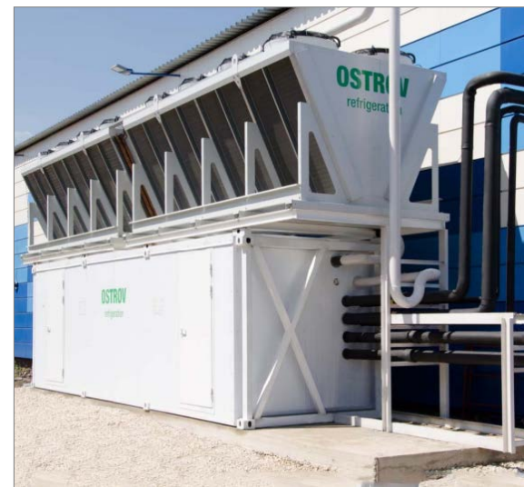
Система холодоснабжения с промежуточным хладоносителем (гликоль, CO 2 )
