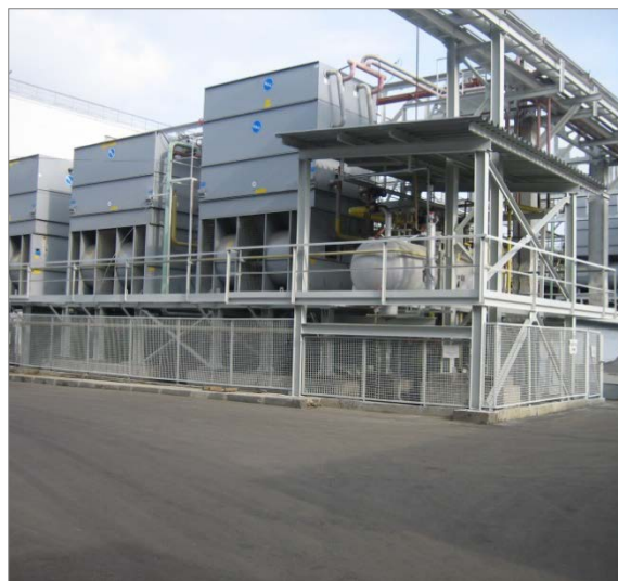
Бустерная транскритическая схема на CO 2
