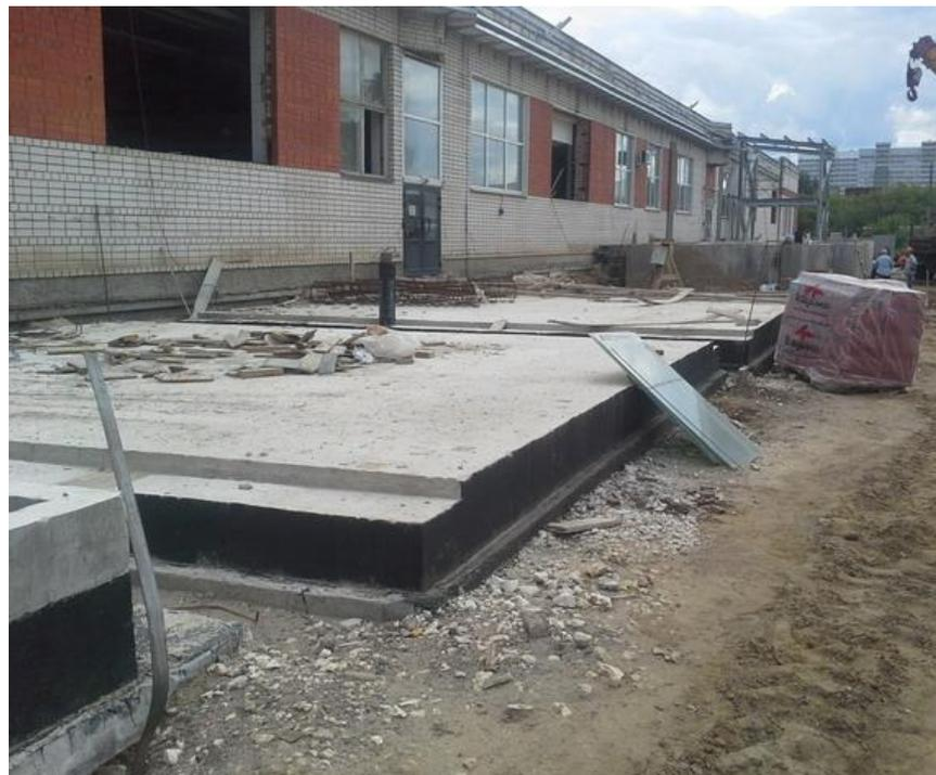
Предварительно подготовленный фундамент на объекте, на котором будет осуществляться сборка модулей в единый блок-бокс
