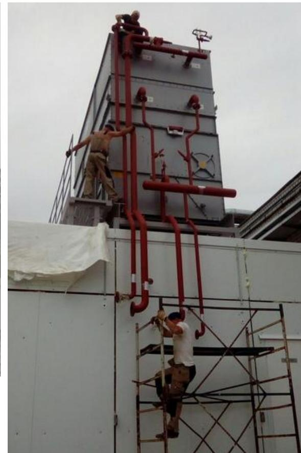
Монтаж **предварительно изготовленных на базе узлов трубопроводов**, отсоединенных для удобства транспортировки на объект отдельных модулей (фланцевые соединения для облегчения сборки)
