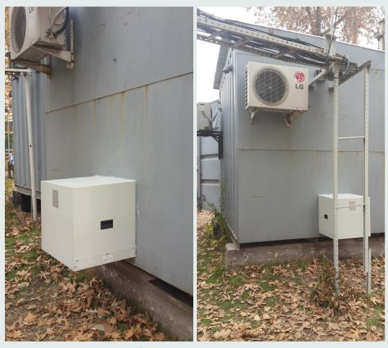
Установленные на базовых станциях ЗАО «Babilon-Mobile», ЗАО «T-cell» и ЗАО «TT mobile» оборудование систем естественного охлаждения (free cooling).
